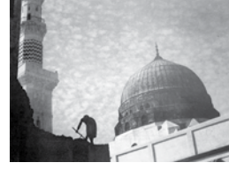
Kubbe-i Hadra'da onarım çalışması.
