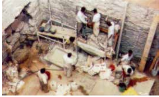
1997'deki Kâbe'nin onarılmasında taşların sökülmesi.
